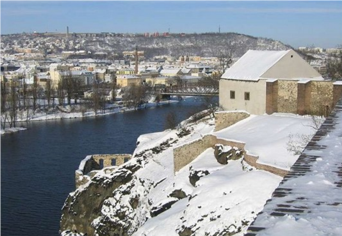
Muro Perimetrale a strapiombo sulla Moldava dove si lanciò il cavallo Šemík
